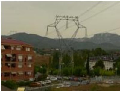
Figura 11. Línia d'alta tensió al barri de Can Trias de Viladecavalls (Barcelona). Font: Enric Carrera
