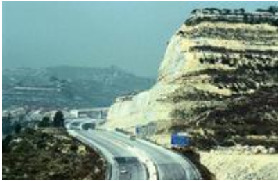
Figura 4. L'autopista Terrassa-Manresa talla sense contemplacions la muntanya per obrir-se pas al terme de Castellbell i el Vilar. Font: Jordi Morató
